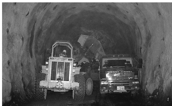
写真-5 タイヤ方式(ずり出し)
