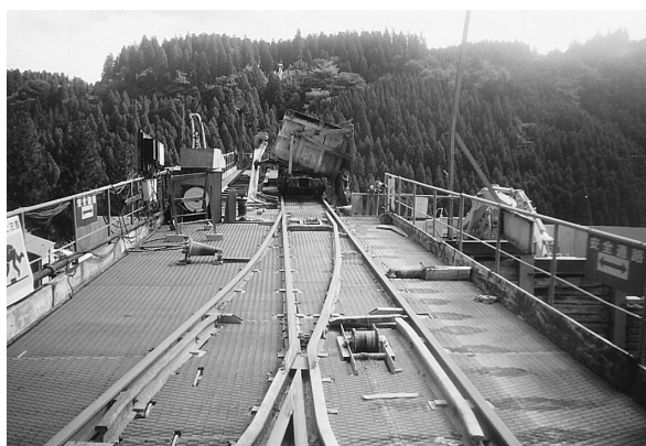
写真-3 レール方式(ずり出し②)
