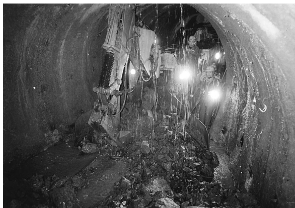
写真-3 レール方式(ずり出し②)
