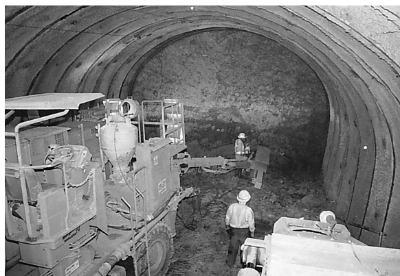
写真-5 タイヤ方式(ずり出し)
