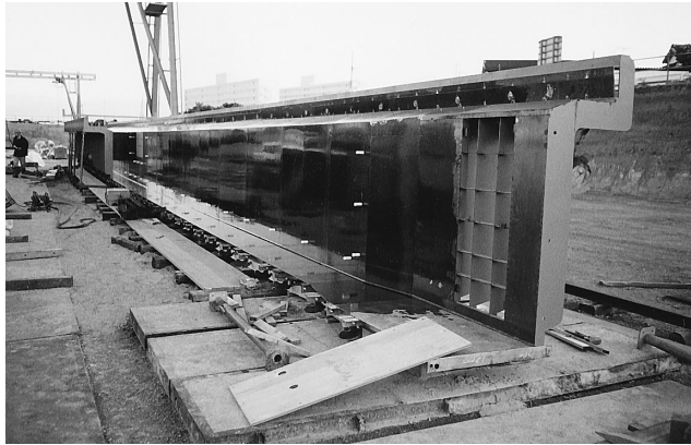
写真－1 鋼製型枠
