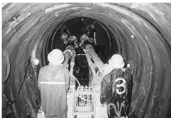
写真-2 レール方式(ずり出し①)
