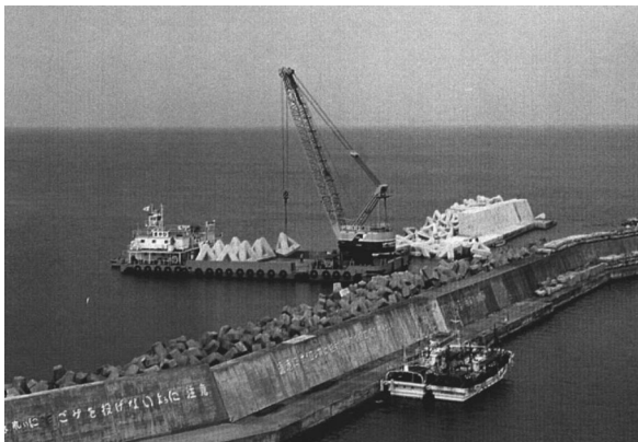
写真 6 ブロック据付作業状況・遠景
