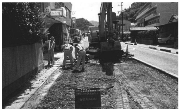
写真 4 バックホウによる舗装版の直接掘削・積込作業状況
