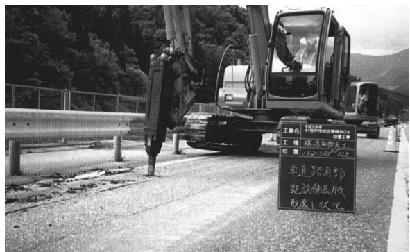
写真 3 コンクリート圧砕機による舗装版の破砕作業状況
