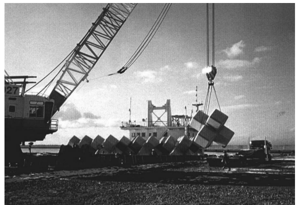
写真 4 作業船運搬状況・クレーン付き台船
