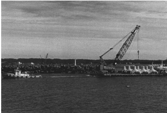
写真 5 作業船運搬状況・起重機船
