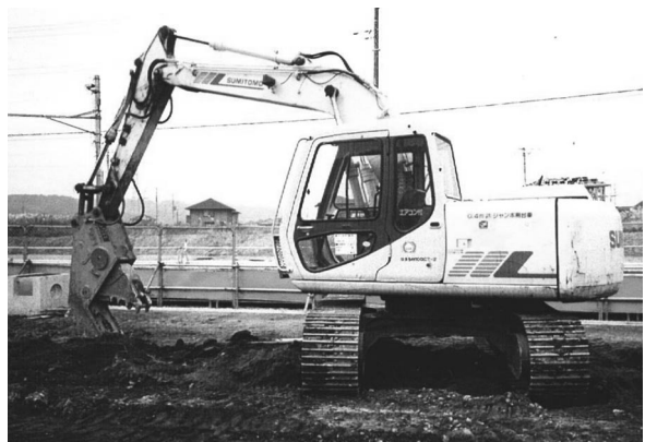
写真 4 バックホウによる舗装版の直接掘削・積込作業状況
