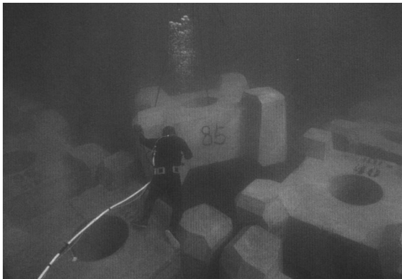
写真 7 ブロック据付作業状況
