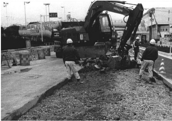
写真 5 破碎後の掘削・積込作業状況
