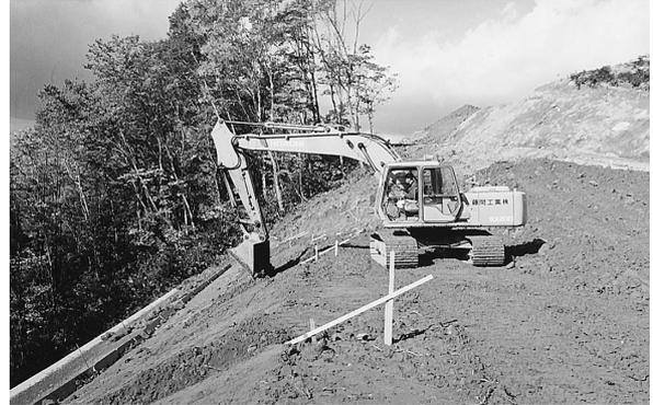
写真 3 機械による築立（土羽）整形
