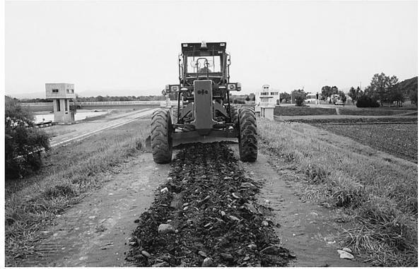
写真 2 補修材の搬入状況
