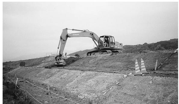
写真 4 機械による切土整形
